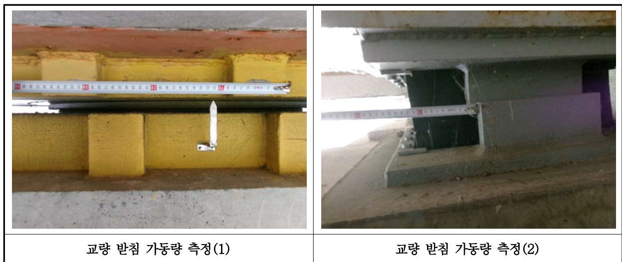
【사진 45.3.20】교량받침 이동량 측정
