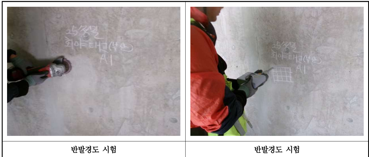
【사진 45.4.2】 반발경도시험 현장사진
