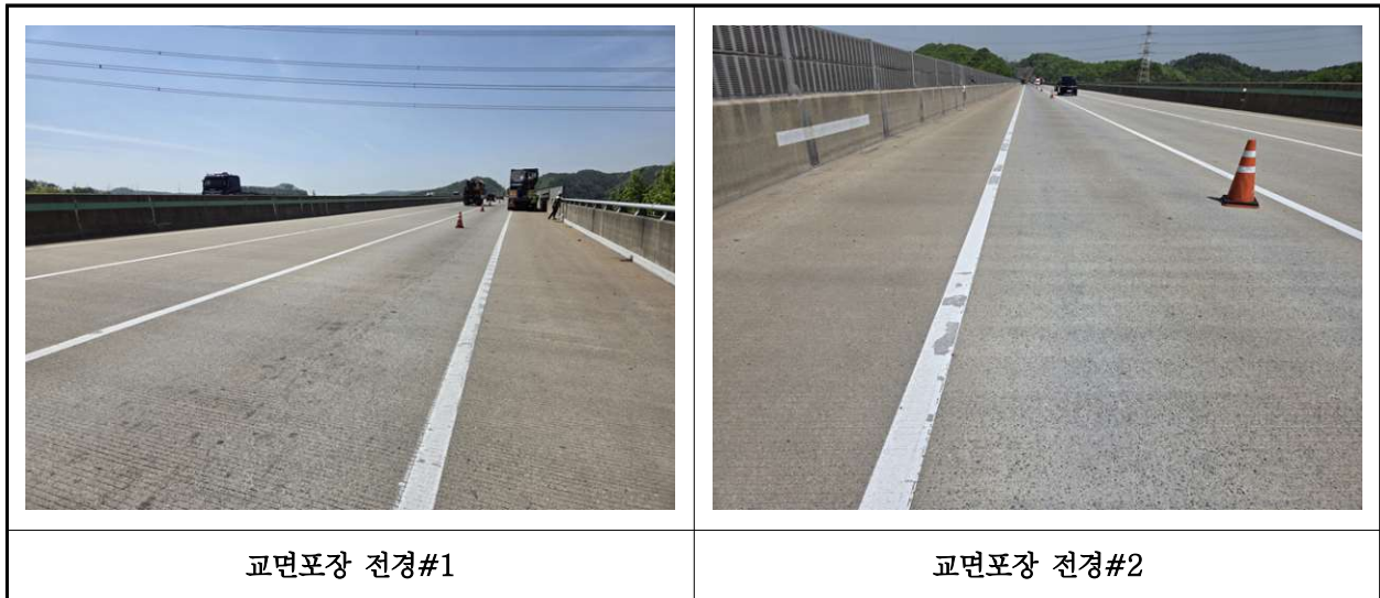
【사진 45.3.24】 교면포장 전경
