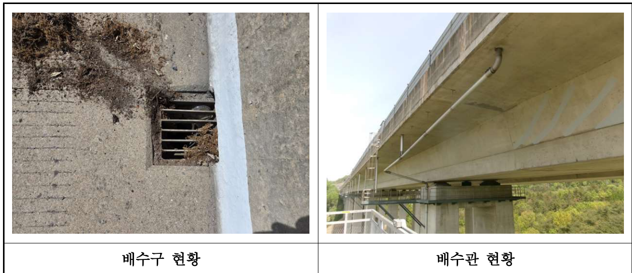
【사진 45.3.26】 배수시설 전경
