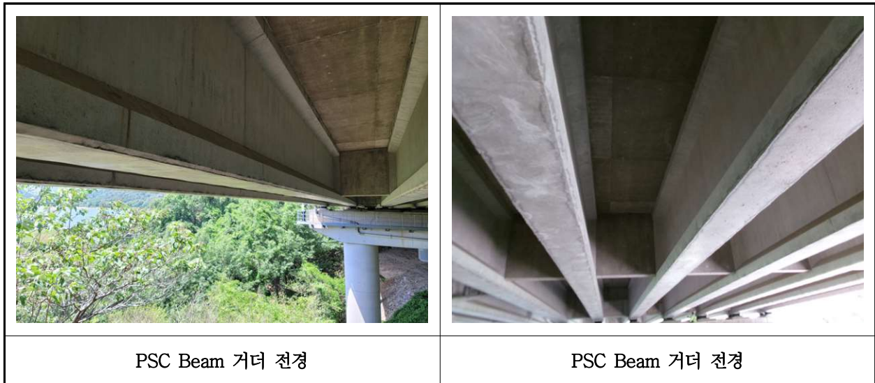
【사진 45.3.8】 PSC Beam 거더 전경
