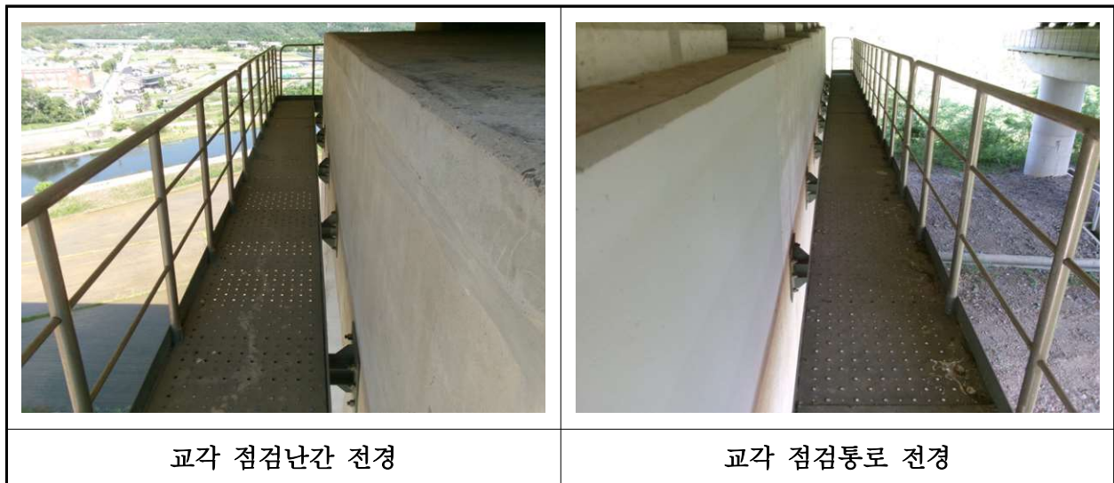
【사진 45.3.30】 교량 점검시설 전경
