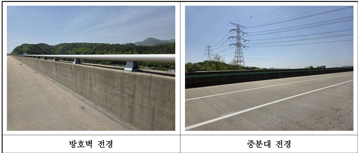
【사진 45.3.28】 방호벽 및 중분대 전경
