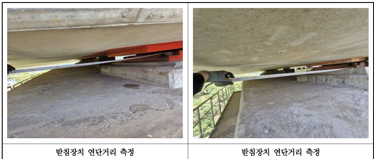
【사진 45.3.19】 교량받침장치 연단거리측정
