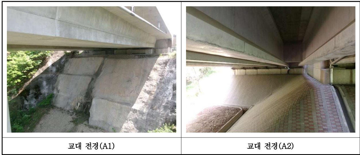
【사진 45.3.12】 교대 전경
